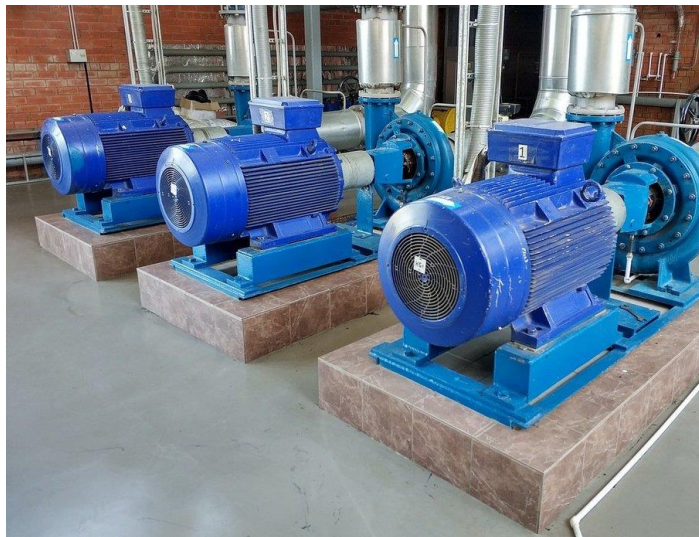
Рис. Масса фундамента должна быть в четыре раза выше массы насосного оборудования
