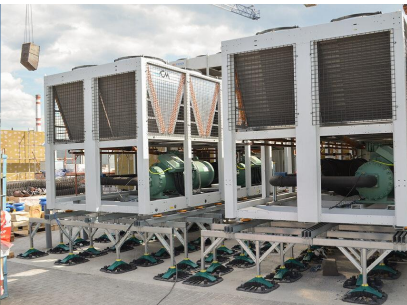
В целях защиты от шума СП не требует применять фундамента для холодильных машин на кровле. Но для защиты пирога кровли чиллеры могут монтироваться на бетонную площадку, фундамента или на опоры типа big foo (см. рисунок справа)
