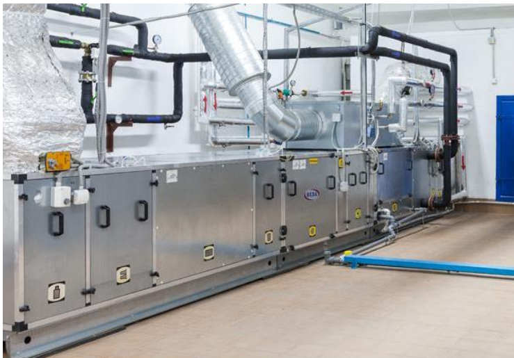
Рис. Вентиляционные установки поставляются на раме и обычно устанавливаются непосредственно на подготовленный пол
