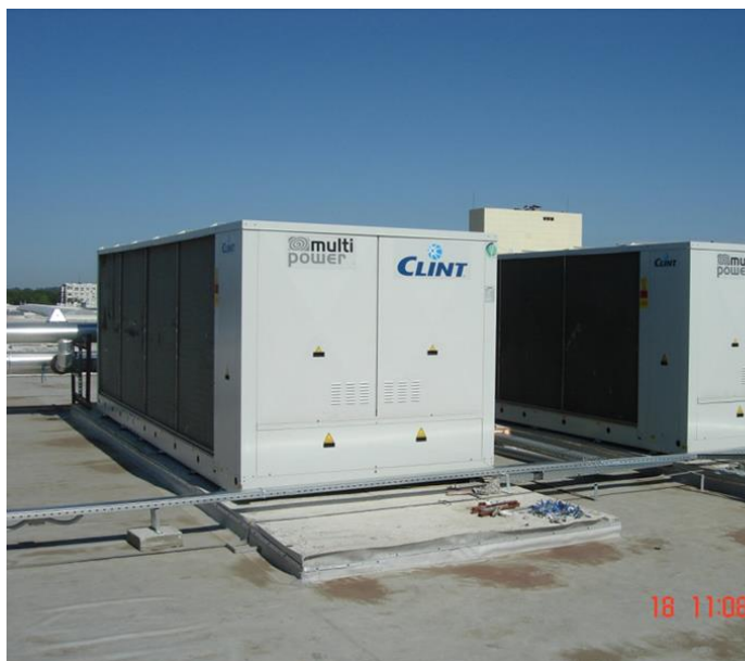
В целях защиты от шума СП не требует применять фундамента для холодильных машин на кровле. Но для защиты пирога кровли чиллеры могут монтироваться на бетонную площадку, фундамента или на опоры типа big foo (см. рисунок справа)
