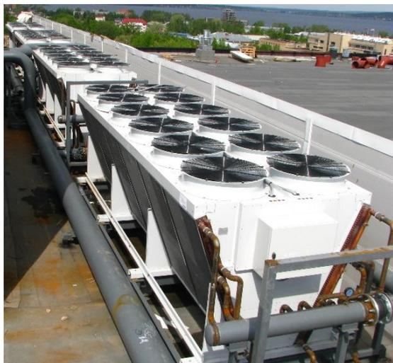
Драйкулер (от англ. dry - сухой и cooler - охладитель) – это расположенный на улице теплообменник, подключаемый к чиллеру, который, в свою очередь, расположен внутри здания. Драйкулеры бывают «плоскими» или V-образными (на фото ←).
