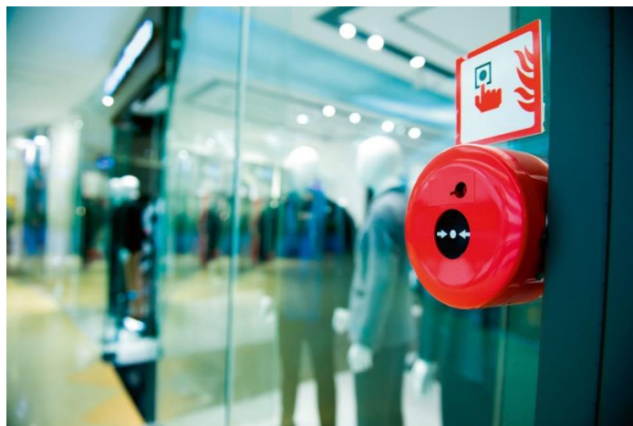
Рис. Корпус ручного извещателя должен выступать из стены по крайней мере на 15 мм
