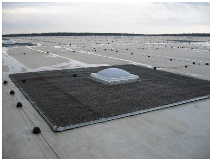
Рис. Защита кровли вокруг люка дымоудаления
