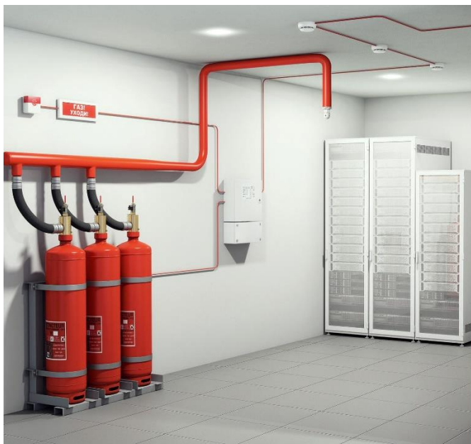
Рис. Баллоны модульных установок могут располагаться как непосредственно в щитовой или аппаратной, так и в смежном помещении
