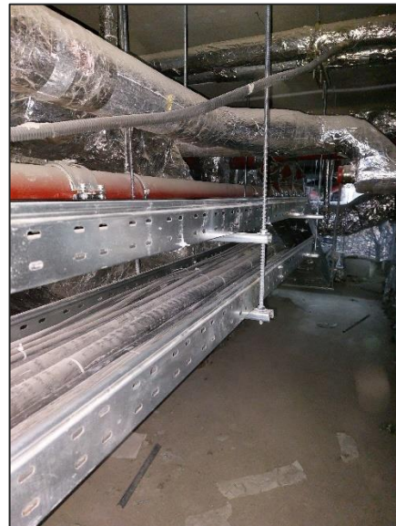
Техническое пространство высотой менее 1,8 метра
