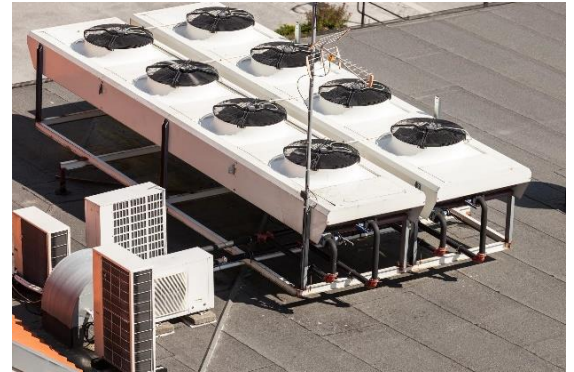
Рис. Наружный блок VRF системы устанавливается в техническом помещении, от него отходит два «комплекта» труб – к драйкулеру и к внутренним блокам. Если традиционный наружный блок VRF охлаждается уличным воздухом напрямую, то водяная VRF использует посредника – контур с антифризом
