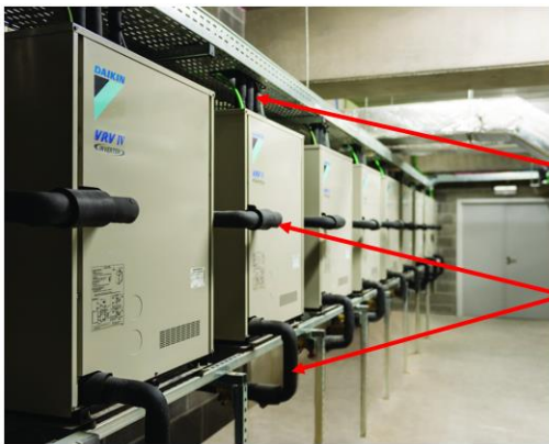
Рис. Наружный блок VRF системы устанавливается в техническом помещении, от него отходит два «комплекта» труб – к драйкулеру и к внутренним блокам. Если традиционный наружный блок VRF охлаждается уличным воздухом напрямую, то водяная VRF использует посредника – контур с антифризом
