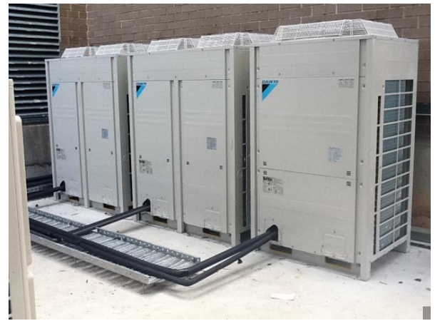
Рис. VRF система отличается от мульти сплит систем тем, что в VRF системе один фреоновый контур вне зависимости от того, сколько установлено внутренних блоков. Клапан понижения давления находится в каждом внутреннем блоке, а не в наружном, как в сплит системах
