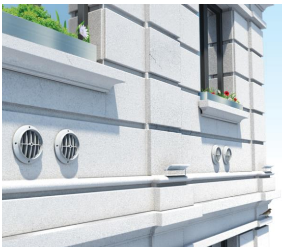
Рис. Отвод тепла на улицу производится вентиляторами через два отверстия в стене диаметром 200 мм
