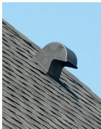
Рис. Забор воздуха не должен выполняться с открытых площадок или крыш, где воздух может перегреться
