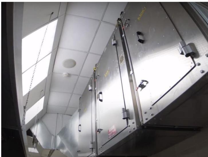
*Рис. Система очистки вытяжного воздуха в ресторане*
