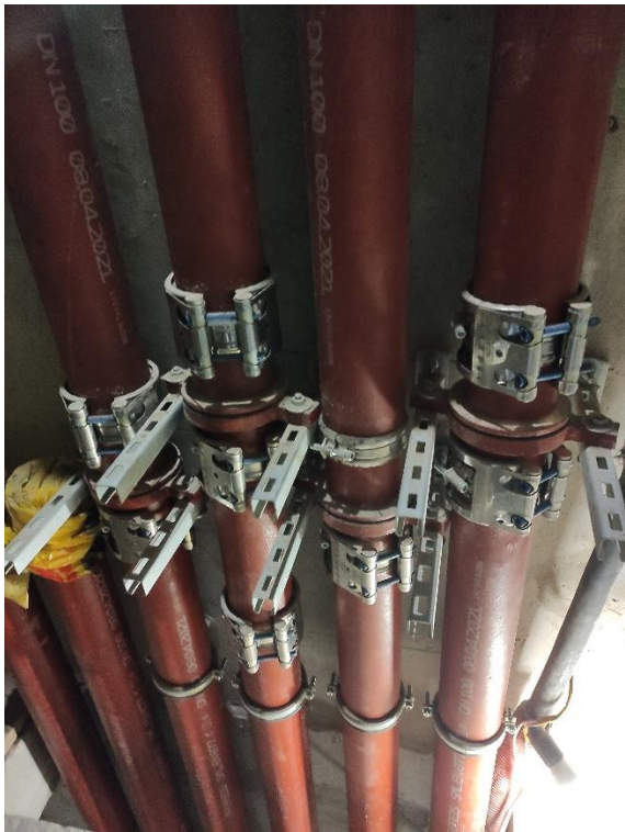
Рис. С учетом опор и хомутов расположить трубопроводы вплотную невозможно, поэтому размеры шахты значительно превышают сечения труб
