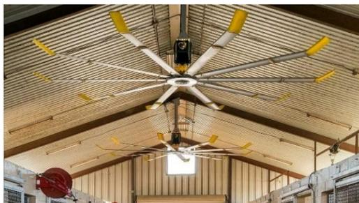
Рис. Научеёмкость HVLS вентиляторов отражается, к примеру, в использовании винглетов (законцовок лопастей), как на авиалайнерах и бизнес джетах
