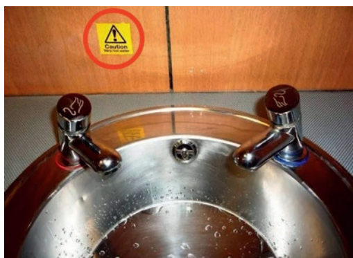
Рис. 5. Схема «с»: чистая холодная вода подается ко всем приборам, а также в емкость (при этом она сразу перестает быть питьевой). Из бака вода поступает к нагревателю, от которого подается к приборам, что и заставляет предпринять «необходимые меры», чтобы горячая вода не попала обратно в городскую сеть. По мнению многих консервативных британцев, лучший способ это сделать – установить два крана
