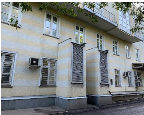
Пристроенные шахты
