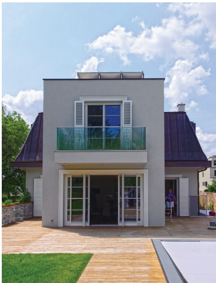
Вилла в Вене. На крыше видны солнечные коллекторы
