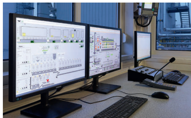
Рис. 5. На монитор диспетчера можно вывести схему любой системы, а также управлять ей, не вставая с рабочего места
