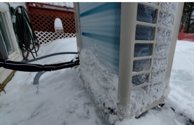
Рис. 4. Наружный блок с замерзшим теплообменником
