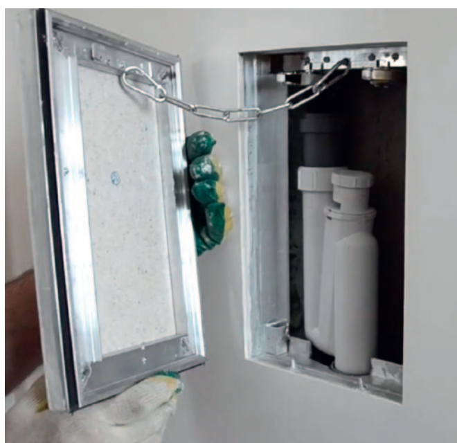
Рис. 3. Лючок напротив гидрозатвора при подключении к стояку
