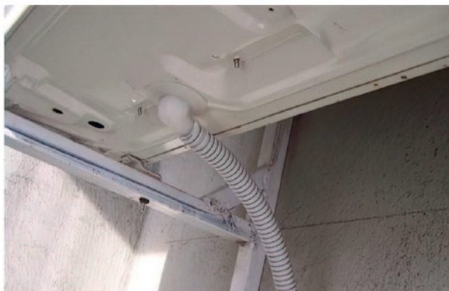
Рис. 5. Слив воды из наружного блока в дренажную систему
