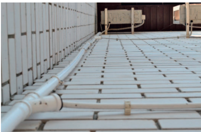
Рис. 6. Такого варианта отвода конденсата в СП нет
