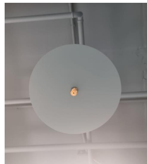
↑ Защита спринклера в местах, где возможно их механическое повреждение
