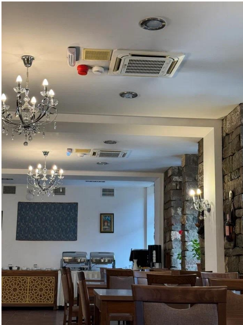
↑ Два датчика установлены вплотную (должно быть не менее 1,2 м) Датчики вблизи решеток (должно быть не менее 1,0 м)
