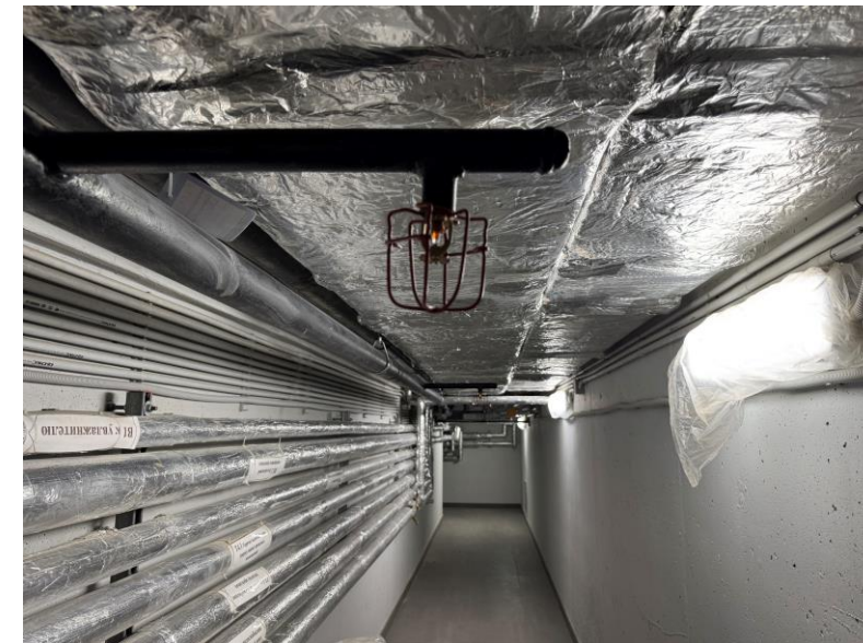
↑ Защита спринклера в местах, где возможно их механическое повреждение
