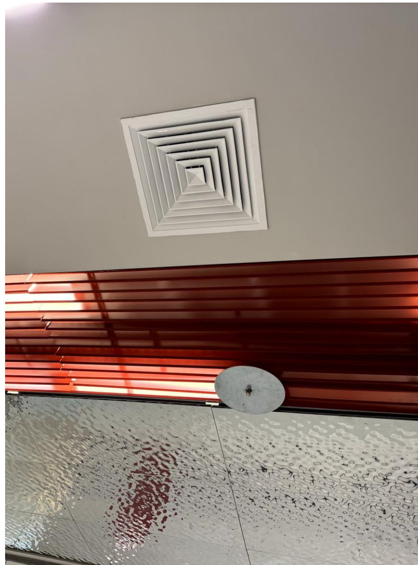
Тепловой экран, который позволяет установить спринклер ниже, чем на 0,3 м от уровня потолка
