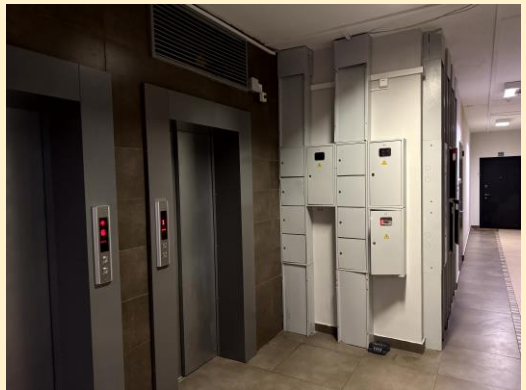
↑ Устройство пристенного типа для кабелей и оборудования электроснабжения и сетей связи. Не предназначено для скрытого монтажа в нишах. Используется в массовом жилье
