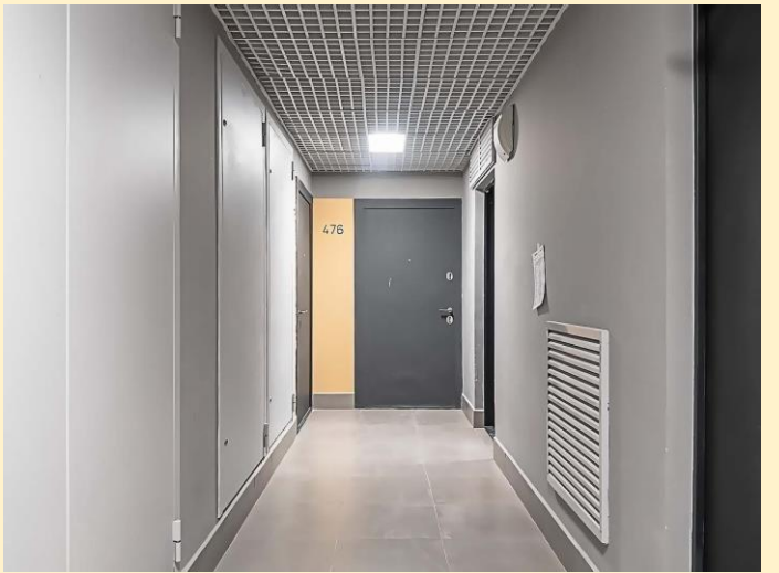
↓ Двери доступа практически по всю высоту этажа. Они применяются для шахт и ниш слаботочных систем и электроснабжения, «двухэтажных» коллекторных узлов
