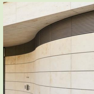
Кастомизация решеток – изогнутая форма ламелей
